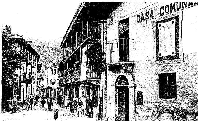
La vecchia Casa Comunale e la via Roma negli anni '30. In fondo l'Albergo dell'Orso.
